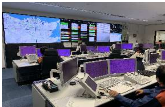
【消防通信指令センター】
